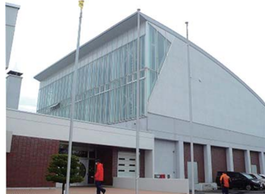
遠別小学校 体育館
