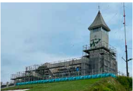
改修工事中的旧とんがりかん
