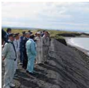
災害復旧工事現場
