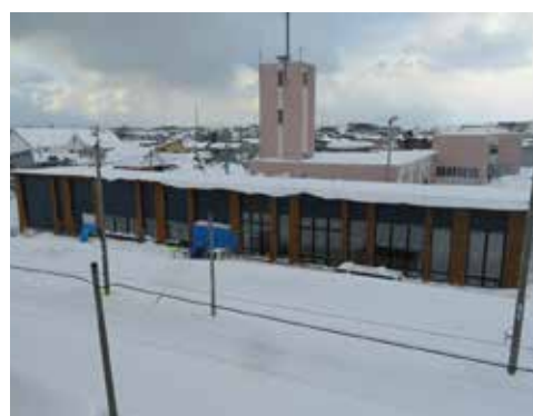
現在建設中のアクティブシニア多世代拠点交流センター (平成30年1月31日 役場3階から撮影)
