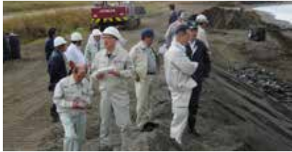
① 北海岸線道路災害応急工事（丸松地区）の状況（丸松）
