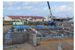
⑦ 道の駅建設工事の状況（富士見）
