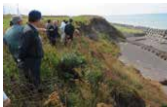
⑥ 金浦地区建設海岸の状況（金浦）
