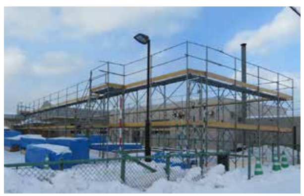
建設（増築）中の男子寮 (1/17 撮影)
