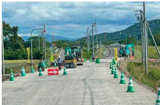
奥島橋架け替えに伴う舗装工事
