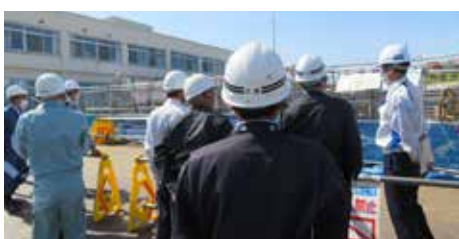
町立診療所建設工事の状況（本町）
