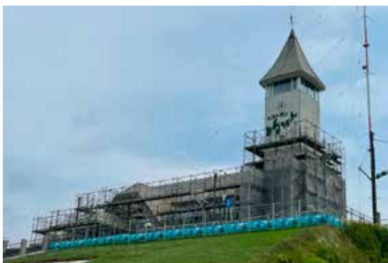
改修工事中の旧とんがりかん
