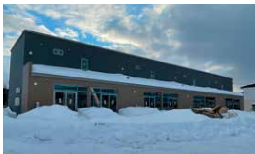
建設中の民間賃貸住宅
