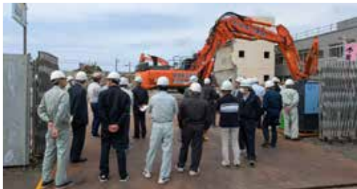
病院及び健康管理センター解体工事の進捗状況
