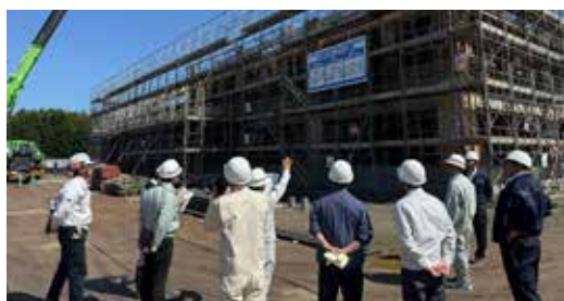
中学校建設工事の進捗状況
